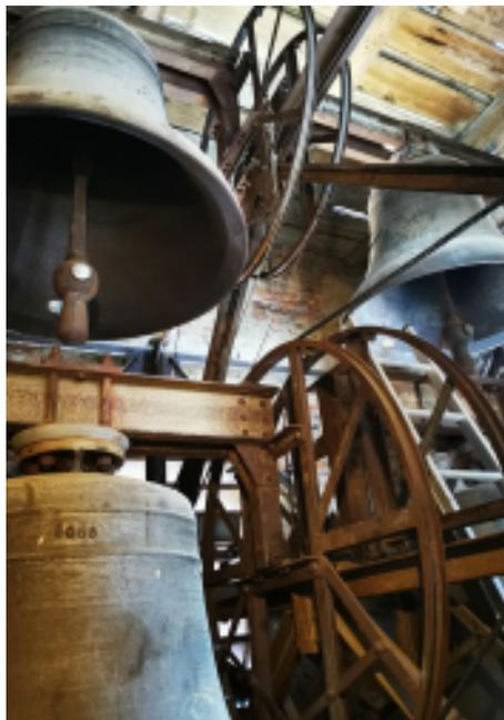
werden müssen, ebenso die Klöppel, die herauszufallen drohen. Die Glocke 4 musste bereits außer Betrieb gesetzt werden.
